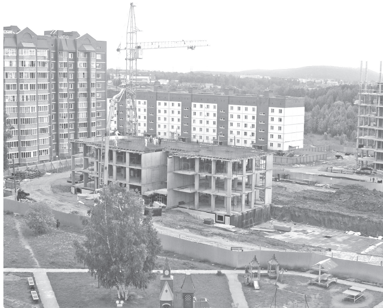
Стройка идёт полным ходом
