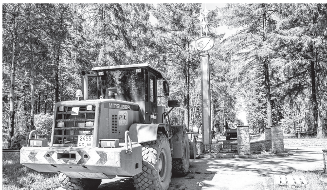
Демонтируется старое оборудование зоны отдыха
