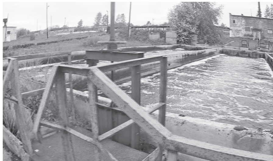
Отстойник очистных сооружений г. Лесного. ФОТО АВТОРА
