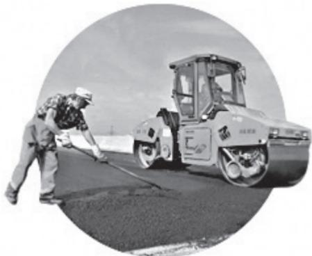
ной смеси. По сути это «жидкий асфальт», он прочно схватывает дорожное полотно, защищает от скорого появления трещин.
