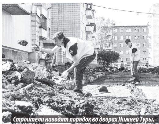
Строители наводят порядок во дворах Нижней Туры.
