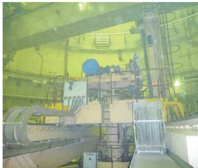
Чистая зона. Сборка реакторной установки. Идут испытания
