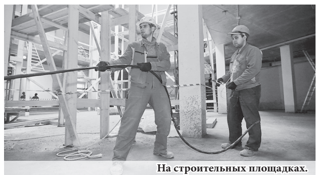
На строительных площадках.
