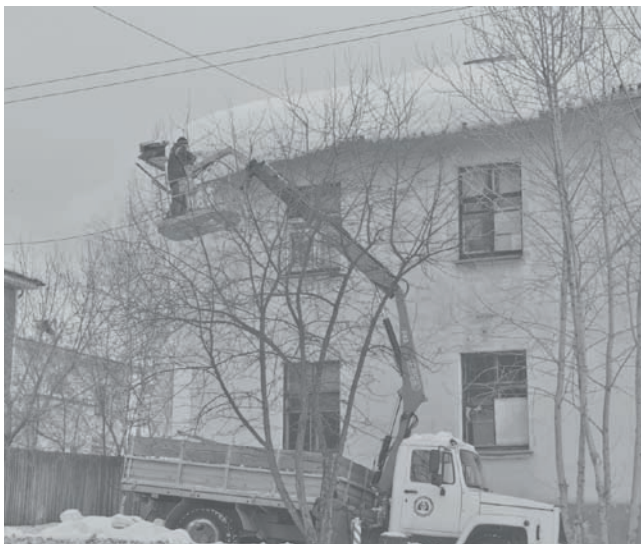
Очистка кровли от снега на ул. Гоголя
