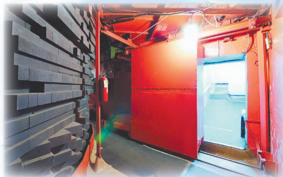
Подземное помещение реактора Ф-1. Слева – графитовая кладка
